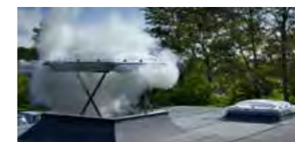
Finestra cupolino per l'evacuazione di fumo e calore
