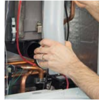
Rimozione collettore fumi
