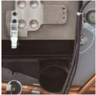
Sblocco raccolta condensa
