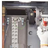
Rimozione del sistema di combustione completo
