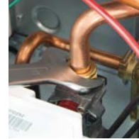
Rimozione del sistema di serraggio della tubazione
