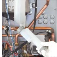
Rimozione sifone condensa
