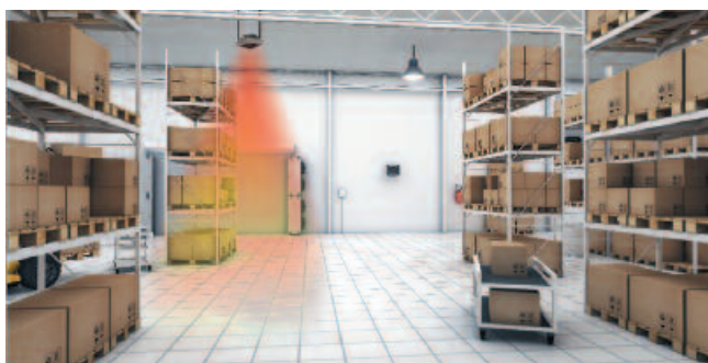
Fase1 - attivazione di destratificatori per spingere verso il basso l'aria calda recuperata dall'area sotto il soffitto
