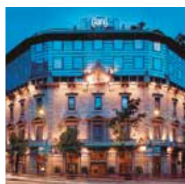
Ristrutturazione Hotel. Il sistema a recupero di calore è l'ideale per un Hotel di questa categoria. Hotel Claris 5*. Barcellona, Spagna. ECOi
