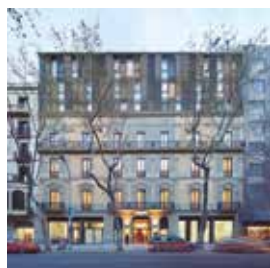
Il nuovo Hotel Vincci Gala con pompa in classe A, risparmio energetico fino al 70%. Barcellona, Spagna. ECOi / ECO G
