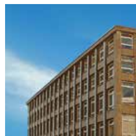
La conversione di un edificio commerciale in un edificio universitario. Bochum, Germania. ECOi
