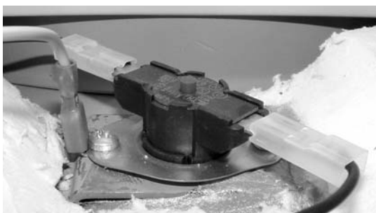
Fig. 23: Pulsante di riarmo del termostato di sicurezza
