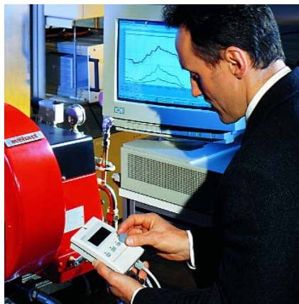
Unità di segnalazione e manovra
