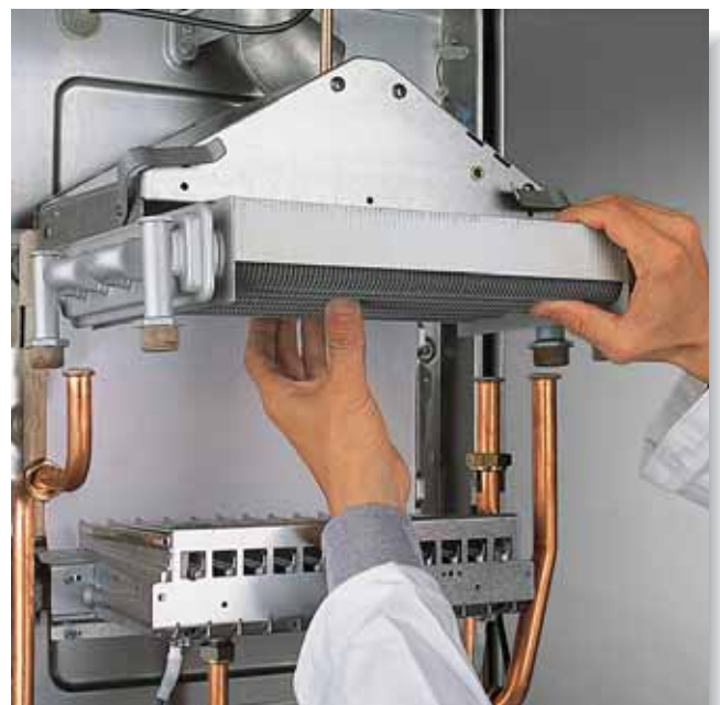
Smontaggio scambiatore a scorrimento frontale
