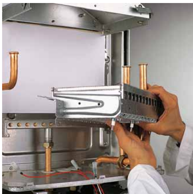
Smontaggio bruciatore scorrimento frontale senza rimozione linea gas
